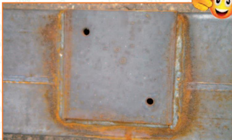
Photo 50 : Trous d'évent et soudure continue
