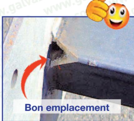
Photos 25 et 26 : Grugeages ou ouvertures dans l'angle
